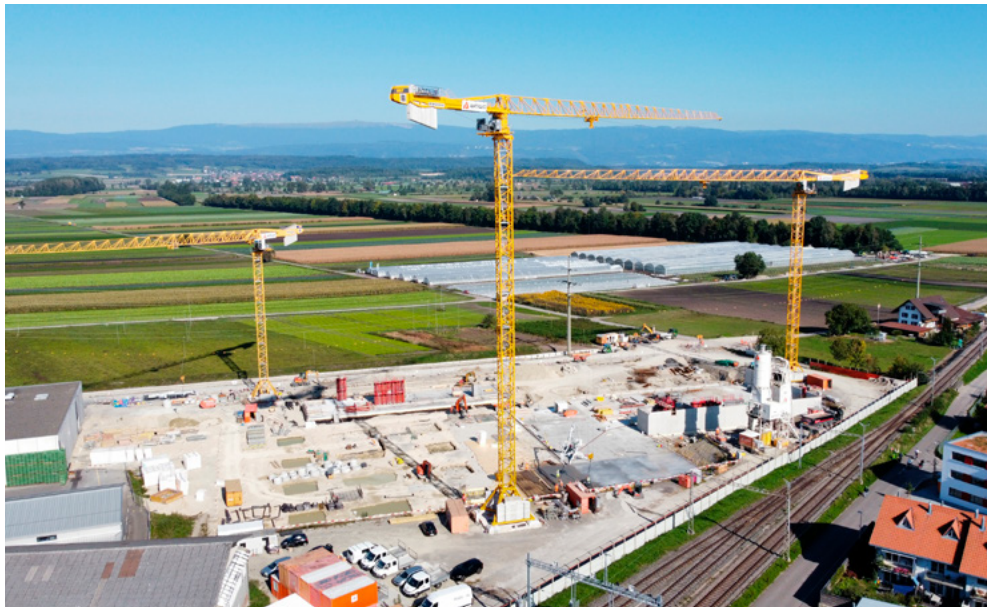
Baustelle im Sommer 2022.
