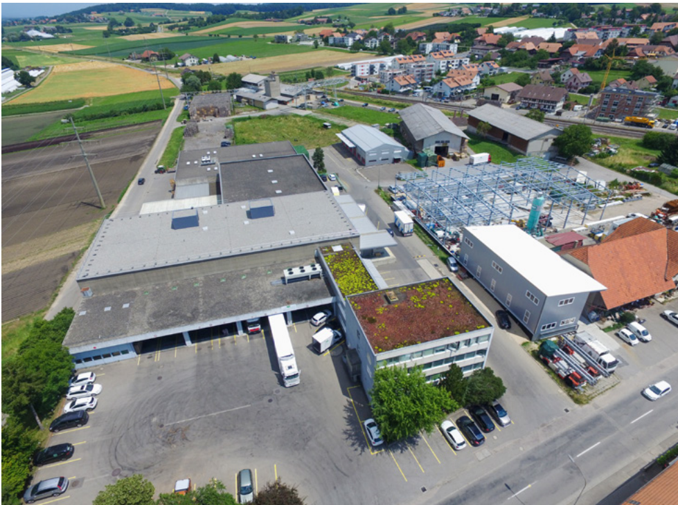
2011 übernahm die Biogemüse AV-AG von der Frilog die ehemaligen SGG-Gebäude an der Moosgasse in Kerzers.
