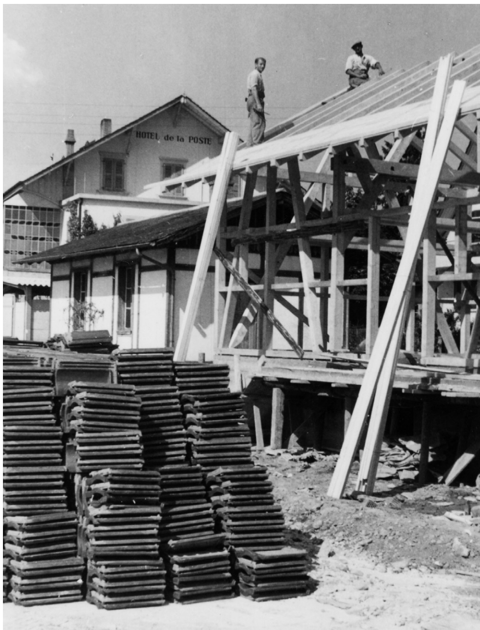
Bau des Genossenschafts- und Lagerhauses beim Bahnhof Kerzers, 1951/52.
